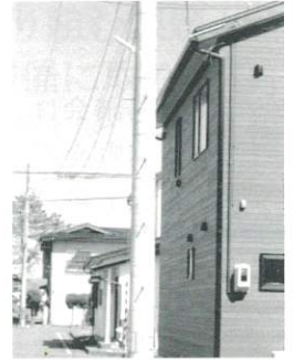
防犯街路灯新設
